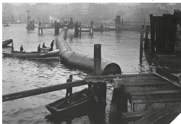
Abbildung 4: Bau der ersten modernen Schwemmkanalisation im Jahr 1856 in Hamburg
