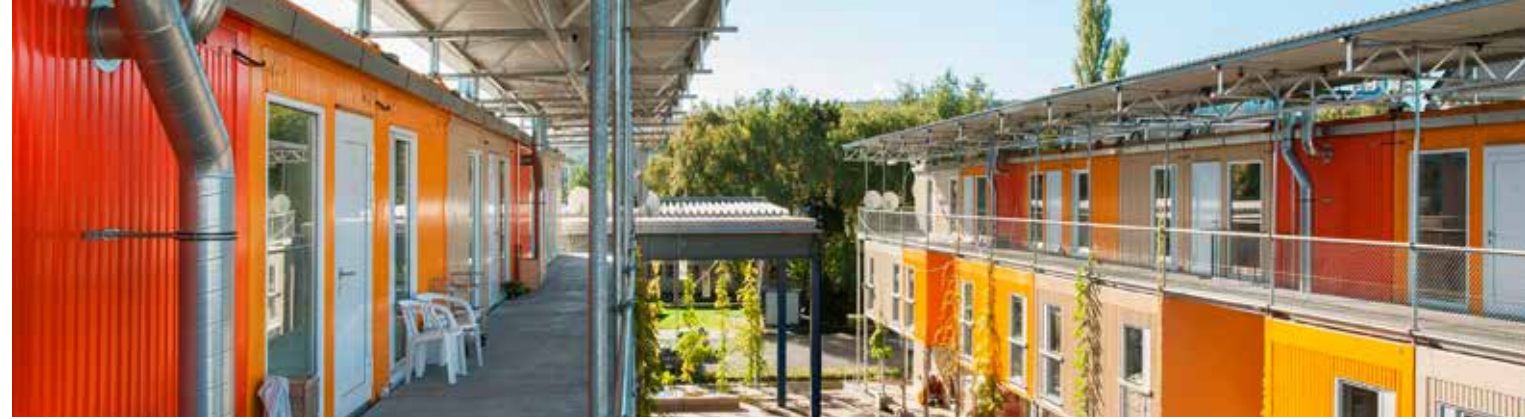
CONTAINERDORF AUS 70 MODULEN IN ZÜRICH
