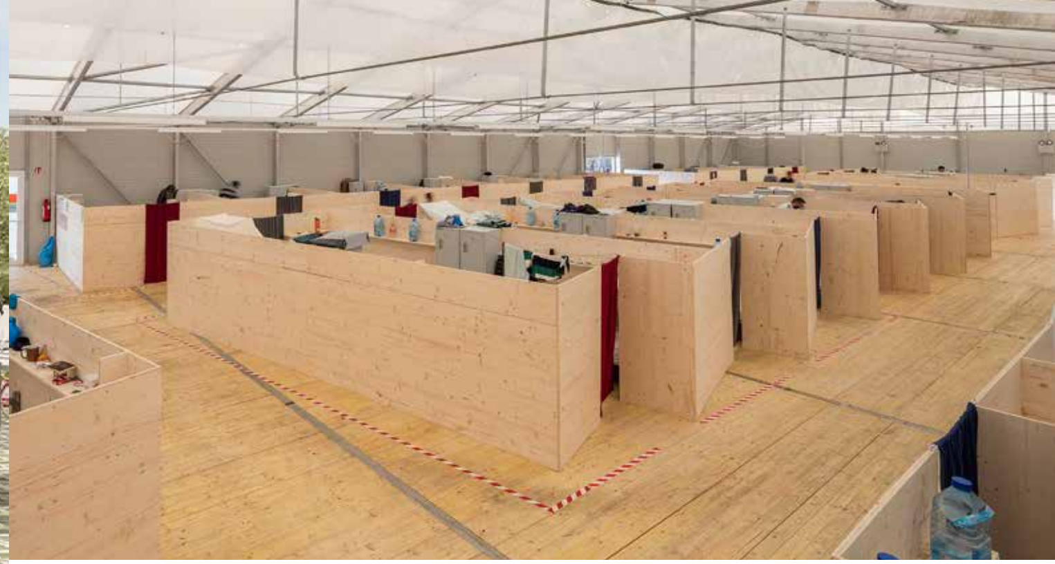
IN MÜNCHEN STEHT DIE LEICHTBAUHALLE, EIN SOGENANNTES KÄFIG-KONZEPT
