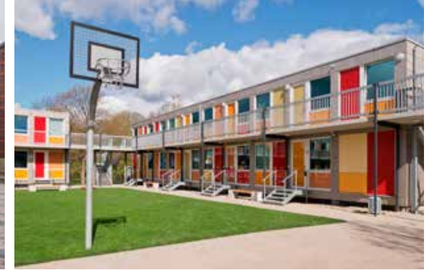
IN HANNOVER STEHEN MEHRERE VORGEFERTIGTE HOLZMODULE.
