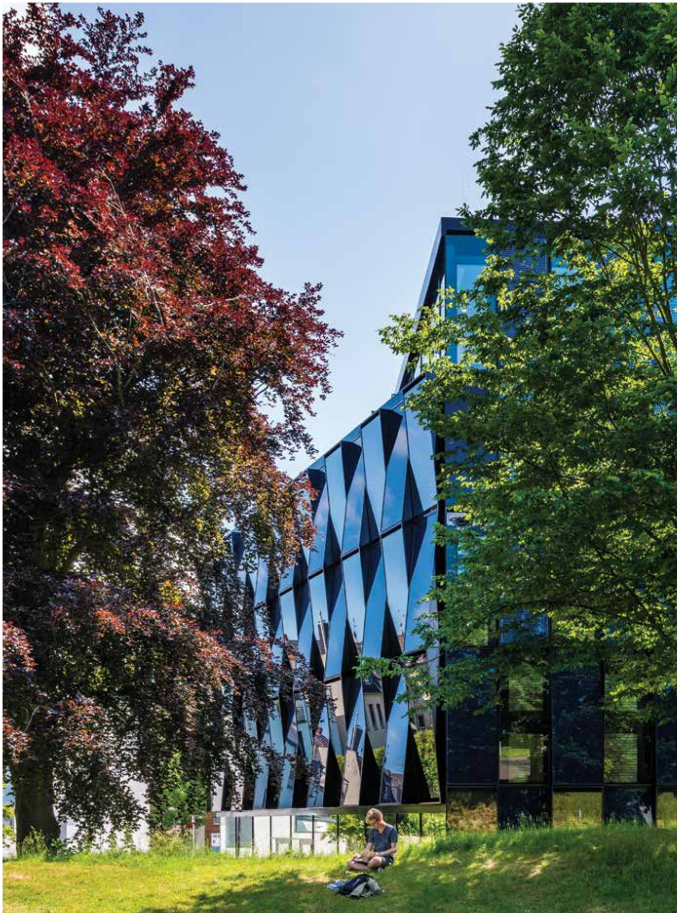
DAS BLAUHAUS IST EIN ARCHITEKTONISCHES MEISTERWERK UND WIRD VON DER HOCHSCHULE NIEDERRHEIN, DEM ENERGIEVERSORGER NEW UND EINIGEN STARTUPS GENUTZT. DAS BLAUHAUS IST ENERGIENEUTRAL.
