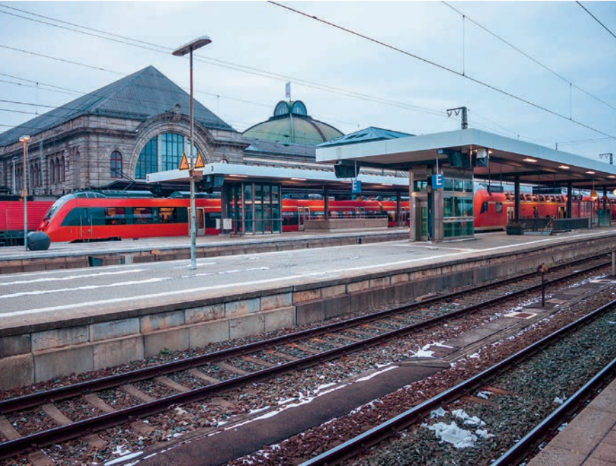
DER NÜRNBERGER HAUPTBAHNHOF.
