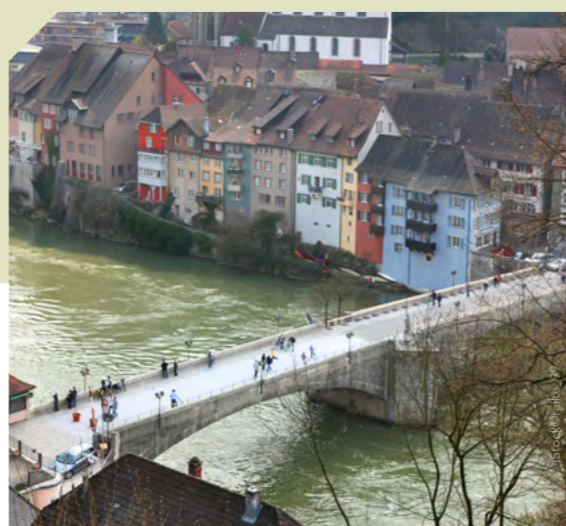
Grenzbrücke Laufenburg, Deutschland/Schweiz
